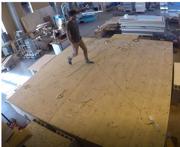
Figure 3 - Essai de marche sur un plancher CLT
